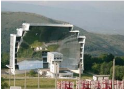
Four solaire de 1 MW th site d'Odeillo
